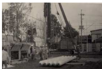
地鎮祭後の工事風景
