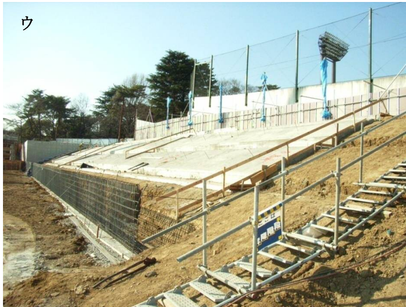
ウ：イの写真から半年過ぎた 2007.2 ごろのバックスタンド 既に松はなく、基礎工事が進んでいた。
