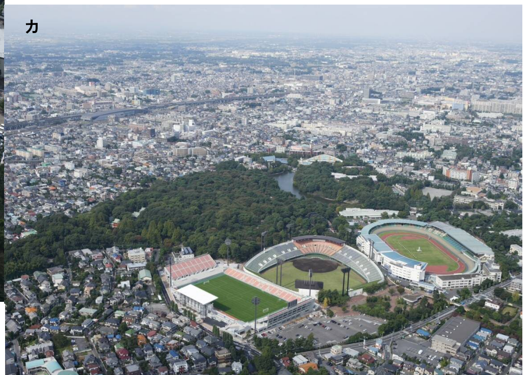
オ・完成直後の北面からの航空写真（撮影：(株)エスエス東京） ※全ての航空写真は、戸田建設（株）様より御提供いただきました。
