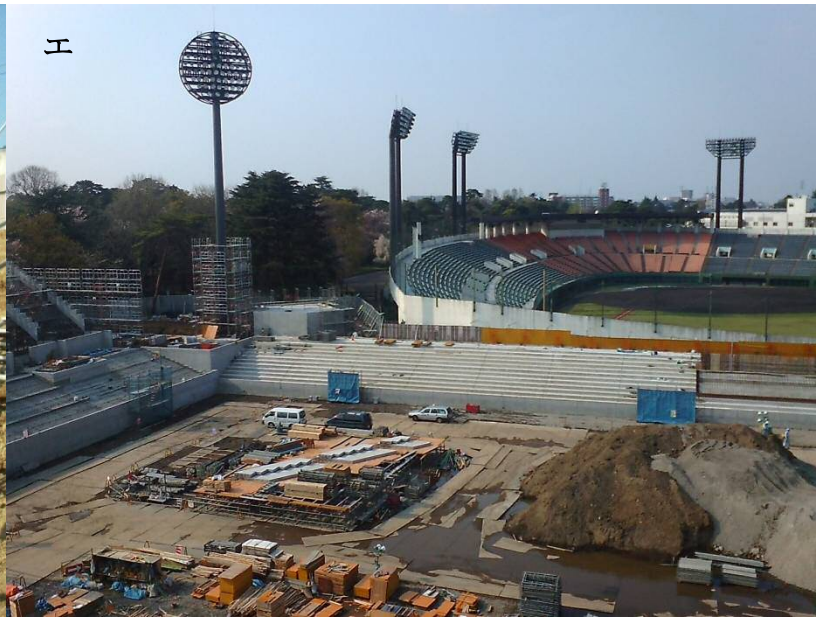
エ：階段状にコンクリートで固められていく。(2007.4 ごろ)
