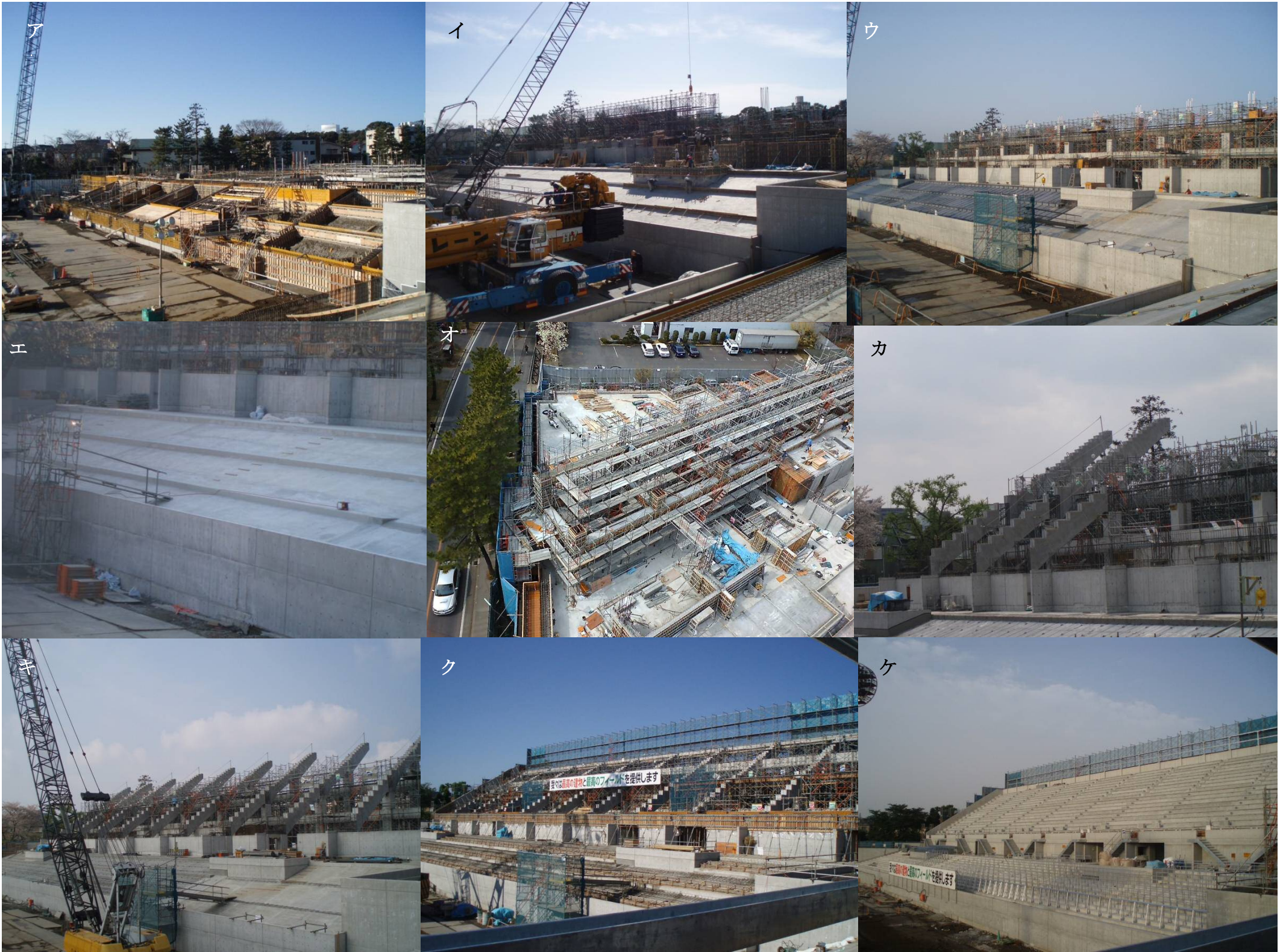
③写真ア～ケ 2007・2～2007・6 ホームゴール裏スタンドの全貌が明らかになっていく
