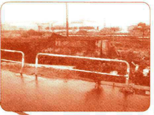
⑤ 伝右川の橋脚跡。奥に続く細長い駐車場も武州鉄道の線路跡。
