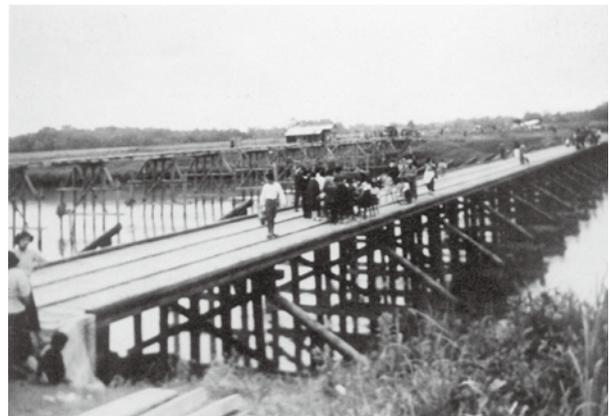
昭和29（1954）年、木造で架け替えられた羽根倉橋（手前）と、秋ヶ瀬橋の古材で造られた旧羽根倉橋（左奥）（提供…さいたま市立浦和博物館）
