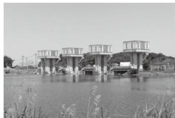
この橋には、元荒川をせき止めて農業用水を取水するための「末田須賀堰」（通称「**おとせき**の堰」）が併設されています。
