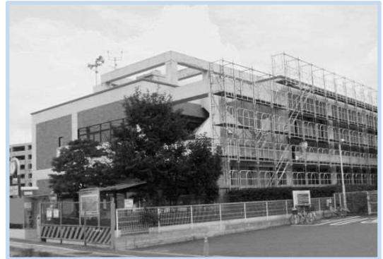
中規模修繕工事中の春野図書館（H28年9月）
